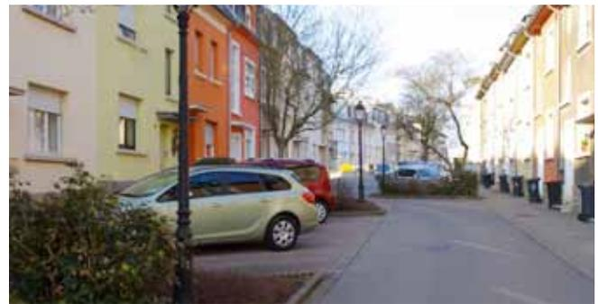
rétrécissement de la chaussée au moyen du stationnement en épis
