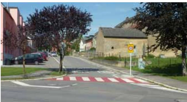
entrée en zone 30km/h - largeur de la chaussée supérieure ou égale à 6m
