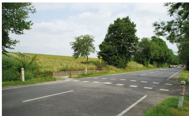
Marquage au sol d'un passage pour cyclistes
