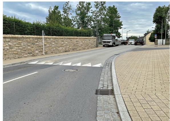
Beispiele für Bremsschwellen bei einer Geschwindigkeitsbegrenzung auf 30 km/h
