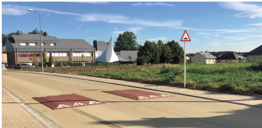
Vorgefertigte Bremsschwellen für eine Geschwindigkeitsbegrenzung auf 30 km/h
