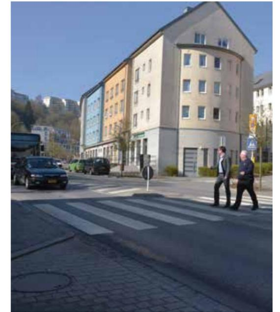
L'îlot médian augmente la sécurité et le confort de la traversée. Cet aménagement est notamment recommandé aux endroits où la largeur de la chaussée est particulièrement importante.
