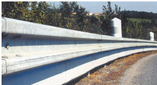
RAILPLAST monté sous glissière métallique
