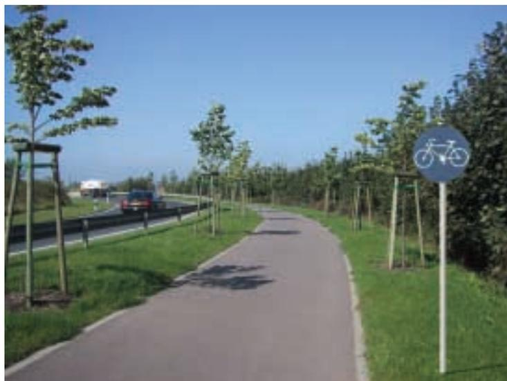
La piste cyclable, doit être séparée matériellement de la chaussée ainsi que d'un éventuel espace réservé aux piétons par une infrastructure de protection (p. ex.: terre-plein, bande de verdure, glissière, boute-roue, ...). La circulation peut s'y faire en sens unique ou à double sens.
