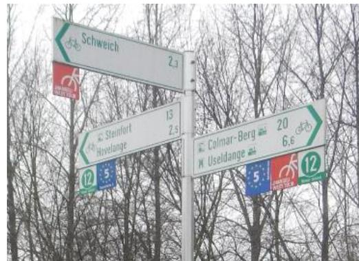
Abbildung 77: Gestufte Montage und 90-Grad-Wegweiser ganz oben wegen Einhalten des Lichtraumprofils
