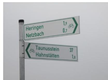
Abbildung 74: Ausnahmemontage der Pfeilwegweiser
