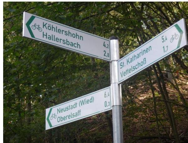
Abbildung 78: Leichte Eindrehung bei (gestufter) Montage von Pfeilwegweisern
