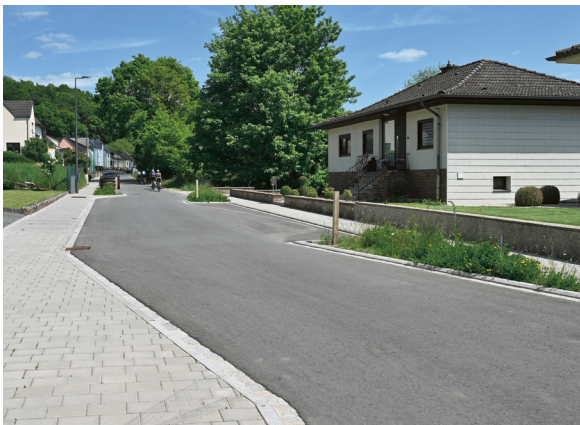
Route de distribution (30 km/h) im ländlichen Kontext
