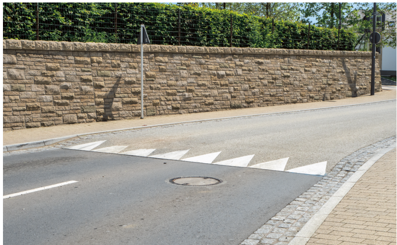
Straßenerhöhung („Plateau“) und heller Fahrbahnbelag auf einem auf 30 km/h beschränkten Abschnitt
