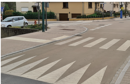
Kreuzung mit Aufpflasterung und hellem Belag
