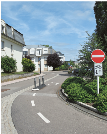
Sicherung der Freigabe in Gegenrichtung für den Radverkehr in einer verkehrsberuhigten Zone
