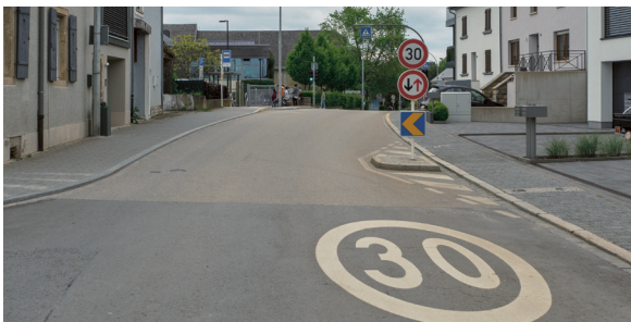
Tronçon limité à 30 km/h aux abords immédiats d'un établissement scolaire
