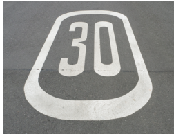
Marquage au sol du signal C,14
