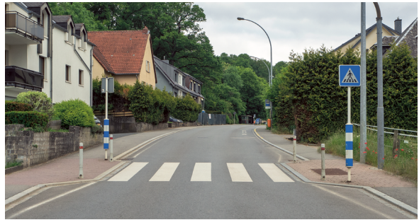
Rétrécissement latéral des deux côtés combiné avec un passage pour piétons non encore aménagé pour les personnes à mobilité réduite (PMR)
