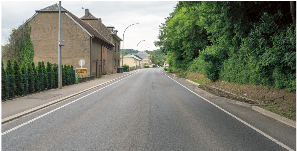
Chaussée avec structuration optique des surfaces latérales - lignes de rive
