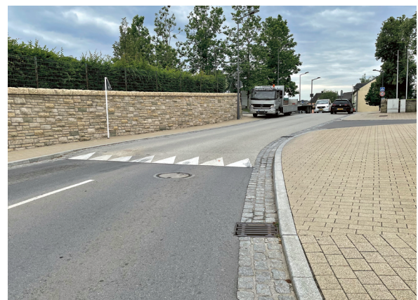
Exemples de ralentisseurs - cas ralentisseur pour une limitation de la vitesse à 30 km/h
