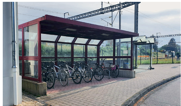
Überdachte Anlehnbügel an einem Bahnhof
