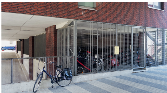
Am Gebäudeeingang (außerhalb der thermischen Hülle)
