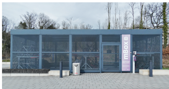
Cage à vélos des CFL (capacité de 56 vélos)
