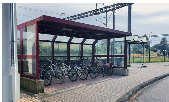
Arceaux vélos protégés contre les intempéries à une gare
