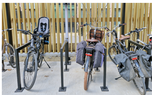
Espacement entre deux essieux de 80cm seulement, donc impossible de fixer deux vélos sur un même arceau
