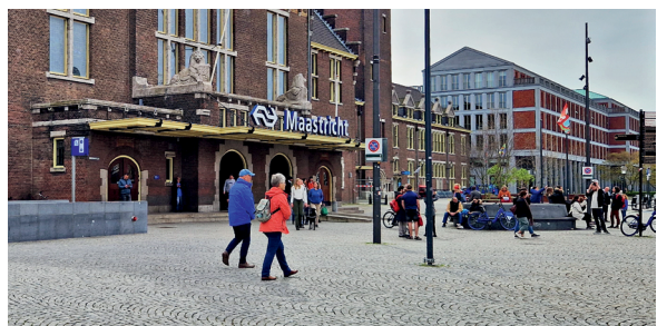
Maastricht : place de la gare après la construction du parking à vélos
