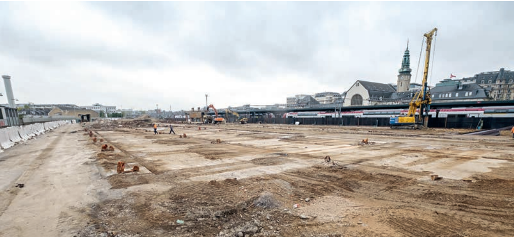
Extension de la gare centrale (CFL)
