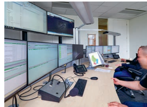
3 Poste de commande (Verkeiersverbond)
