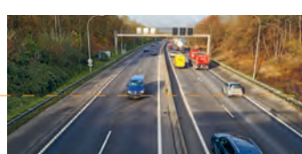
AUTOBAHN ODER SCHNELLSTRASSE
