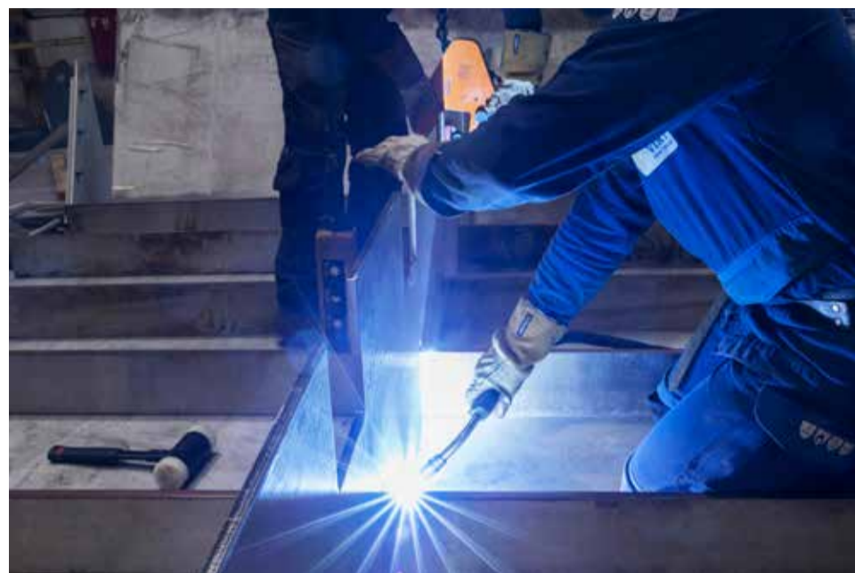
Soudures des éléments qui porteront le tablier.
