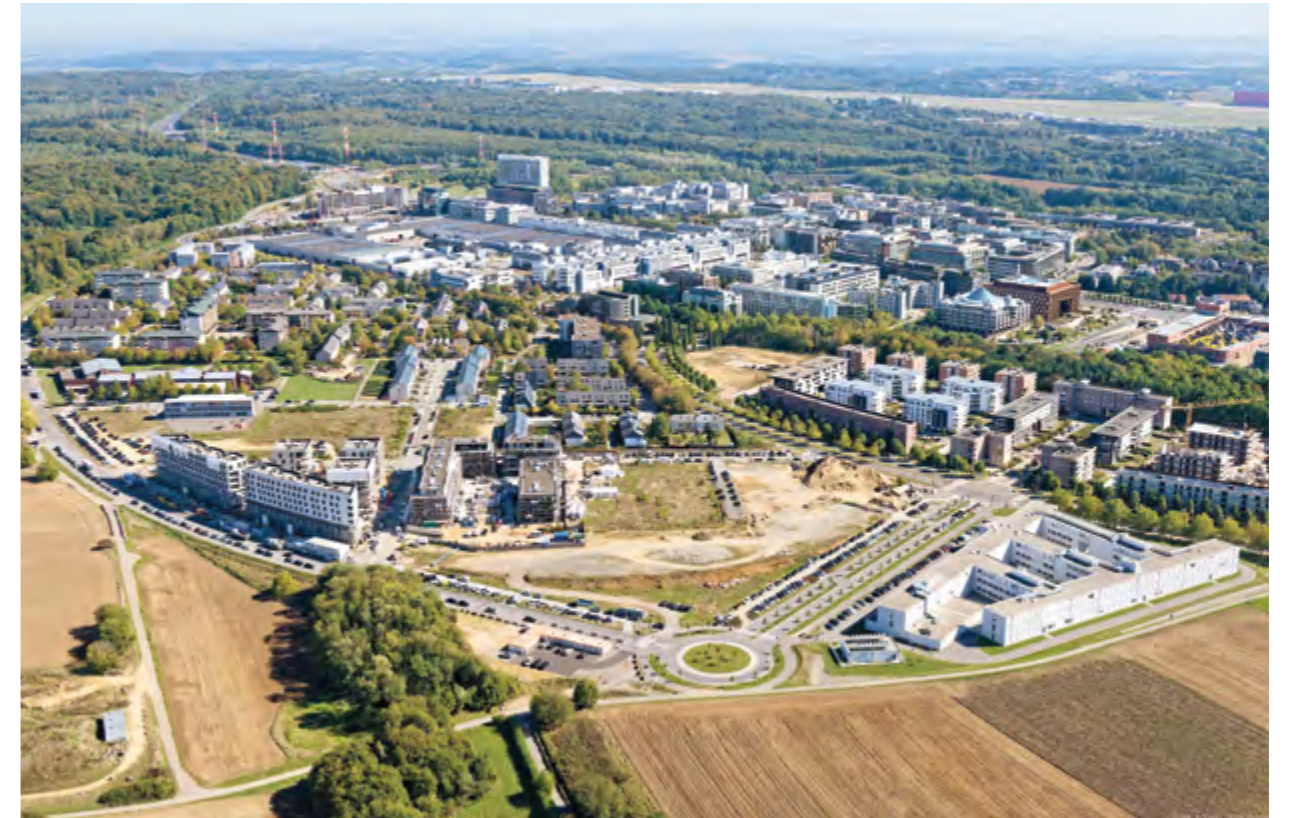
De nombreux appartements sont actuellement en construction au quartier du Kiem. A large number of apartments are presently under construction in the Kiem District.
