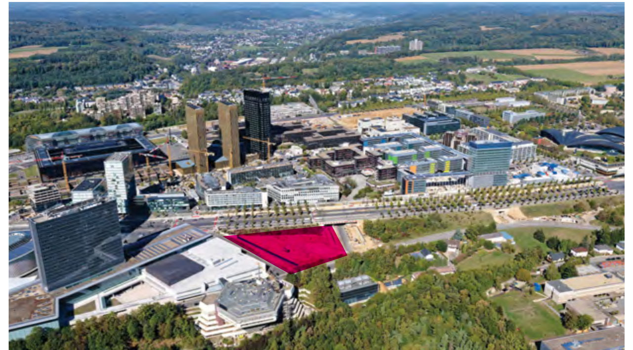
Le site de construction du nouveau siège mondial d'ArcelorMittal Construction site of ArcelorMittal's new world head office
