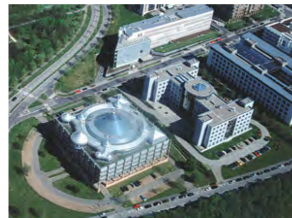
Vue aérienne de la rue Jean Monnet et des bâtiments en solitaires Aerial view of the rue Jean Monnet and of the solo buildings
