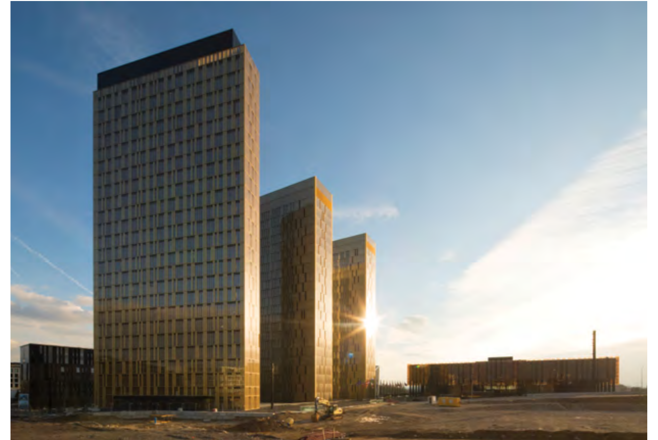
La tour C de la Cour de justice de l'Union européenne représente aujourd'hui le bâtiment le plus haut du Luxembourg. Elle mesure 118 mètres. Tower C of the Court of Justice of the European Union is now, at 118 metres, the tallest building in Luxembourg.
