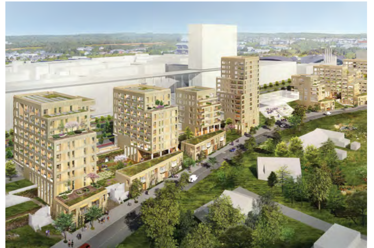
L'architecture en gradins fait le maillage entre le Weimershof et le Plateau de Kirchberg. The stepped architecture links Weimershof with the Kirchberg Plateau.
