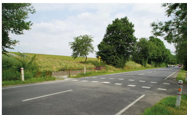
Marquage au sol d'un passage pour cyclistes
