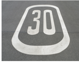
Marquage au sol du signal C,14
