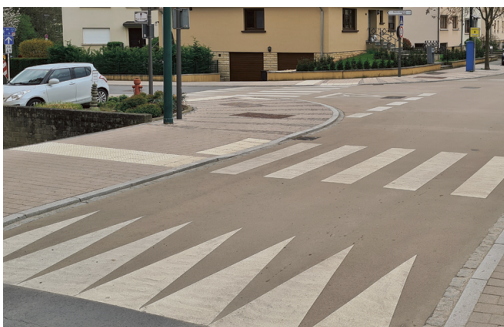
Carrefour surélevé avec revêtement clair
