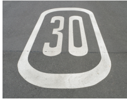
Marquage au sol du signal C,14
