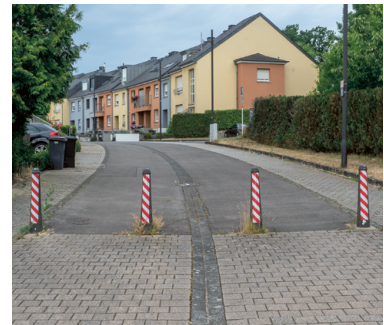
Impasse franchissable aménagée avec des bornes fixes
