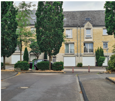
Impasse franchissable avec un rétrécissement bâti sous forme d'un îlot de verdure
