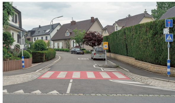
Passage pour piétons sur fond rouge: aménagement à ne plus prévoir pour les nouveaux projets d'entrée en zone 30 km/h
