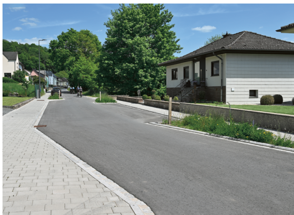
Route de distribution (30 km/h) dans un contexte rural
