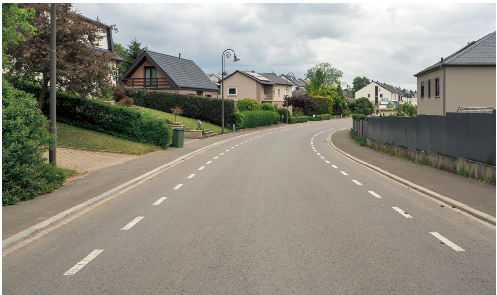
Chaussée avec structuration optique des surfaces latérales - voies suggestives
