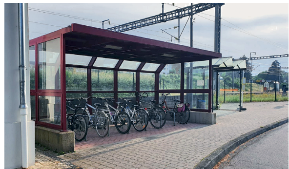
Arceaux vélos protégés contre les intempéries à une gare
