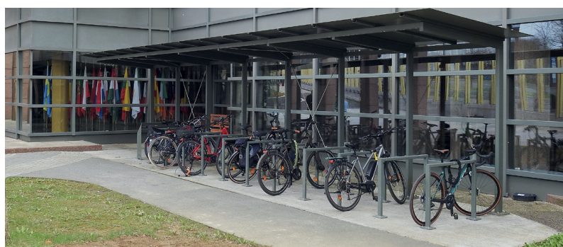
Emplacement à proximité de l'entrée, visible de l'intérieur et protégé contre les intempéries
