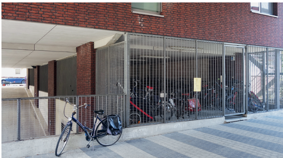
À l'entrée du bâtiment (en dehors de l'enveloppe thermique)
