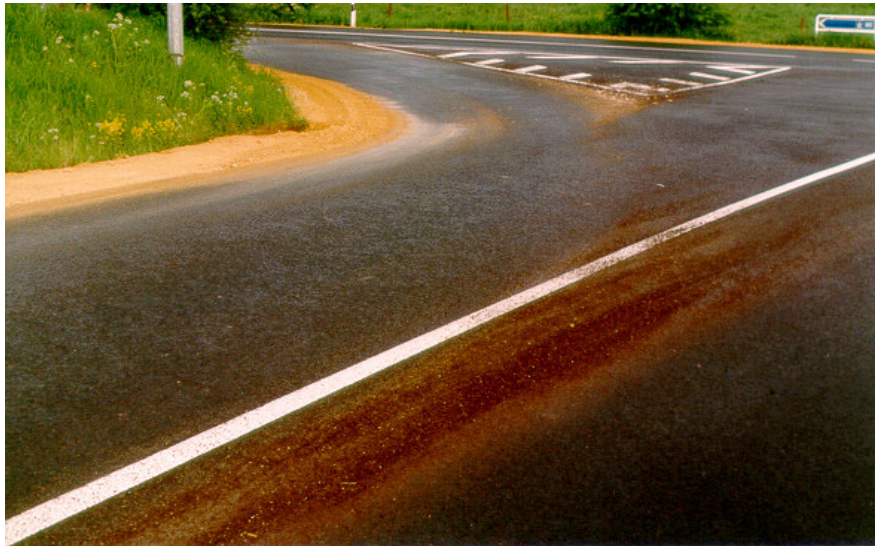
accotement en concassé de carrière 0/50 – croisement Dudelage – Noertzange (photo LMI)
