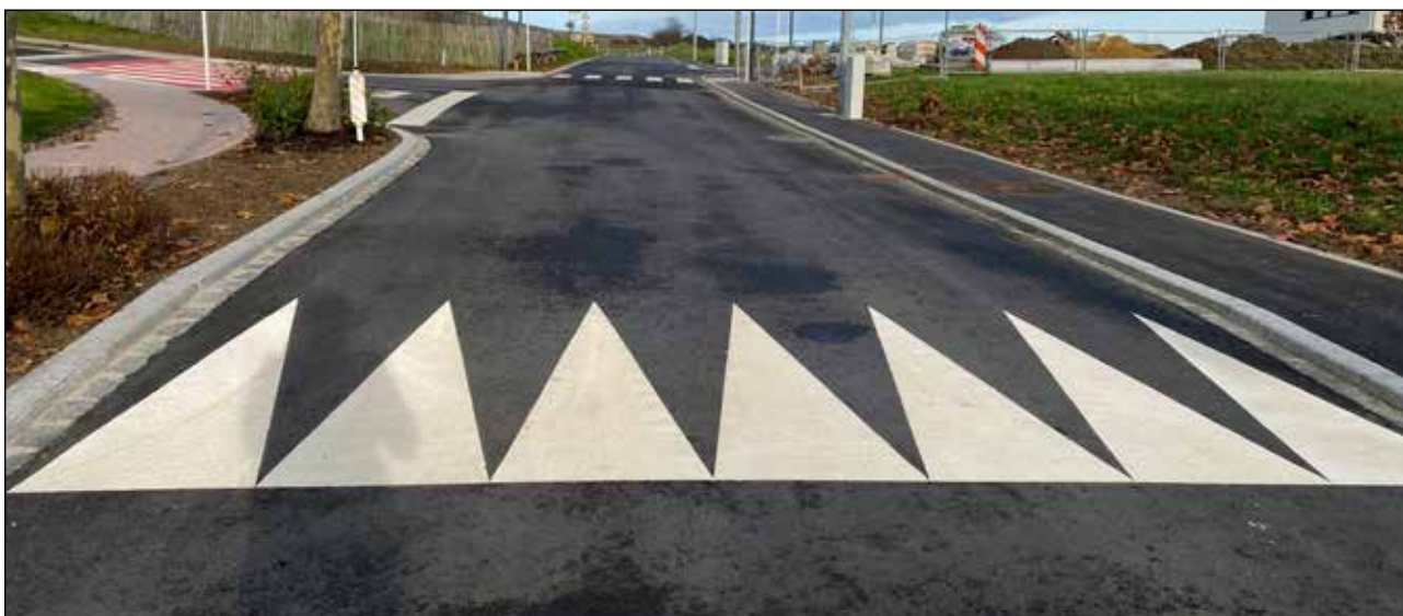
Projet pilote du carrefour surélevé à Mondorf-les-Bains
