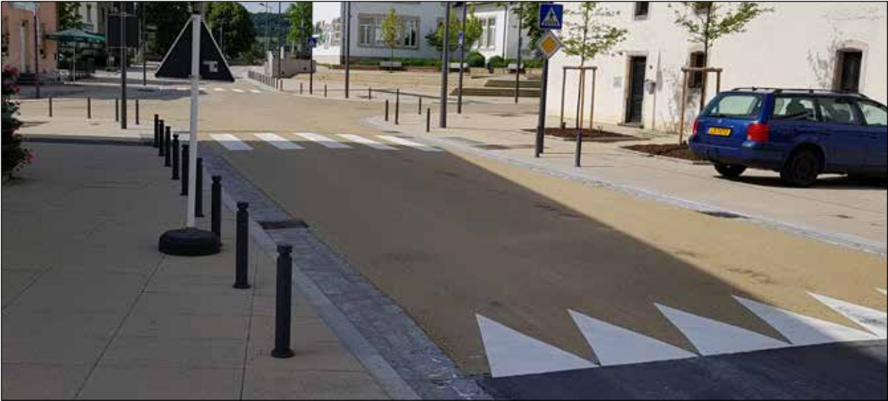
Exemple tronçon «vitesse 30» à Bascharage
