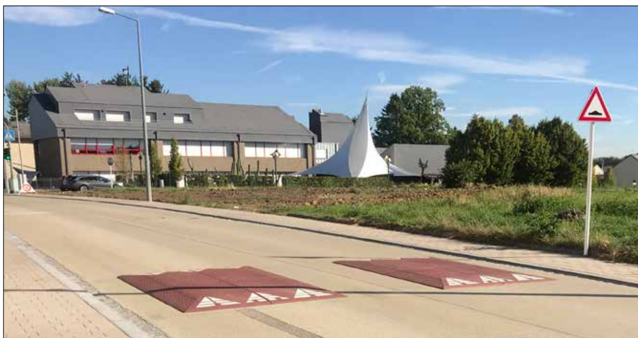
Exemple de ralentisseur - ralentisseur préfabriqué pour 30 km/h
