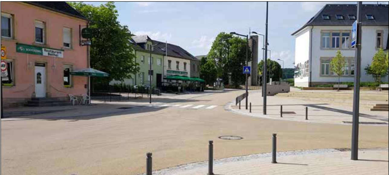
Exemple tronçon «vitesse 30» à Bascharage
