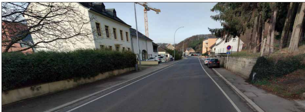
Chaussée avec structuration optique des surfaces latérales – lignes de rive
