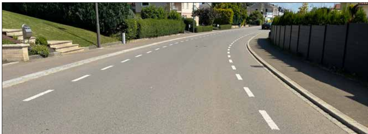
Chaussée avec structuration optique des surfaces latérales – voies suggestives
